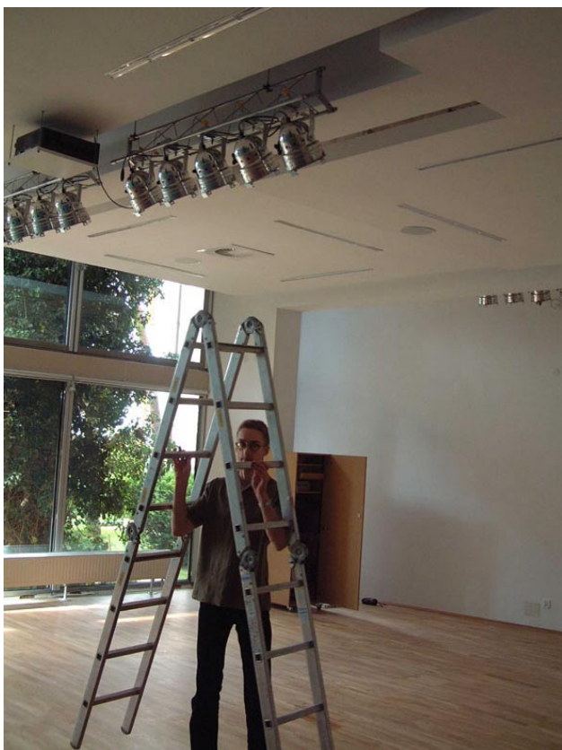
Montaż głośników sufitowych...
