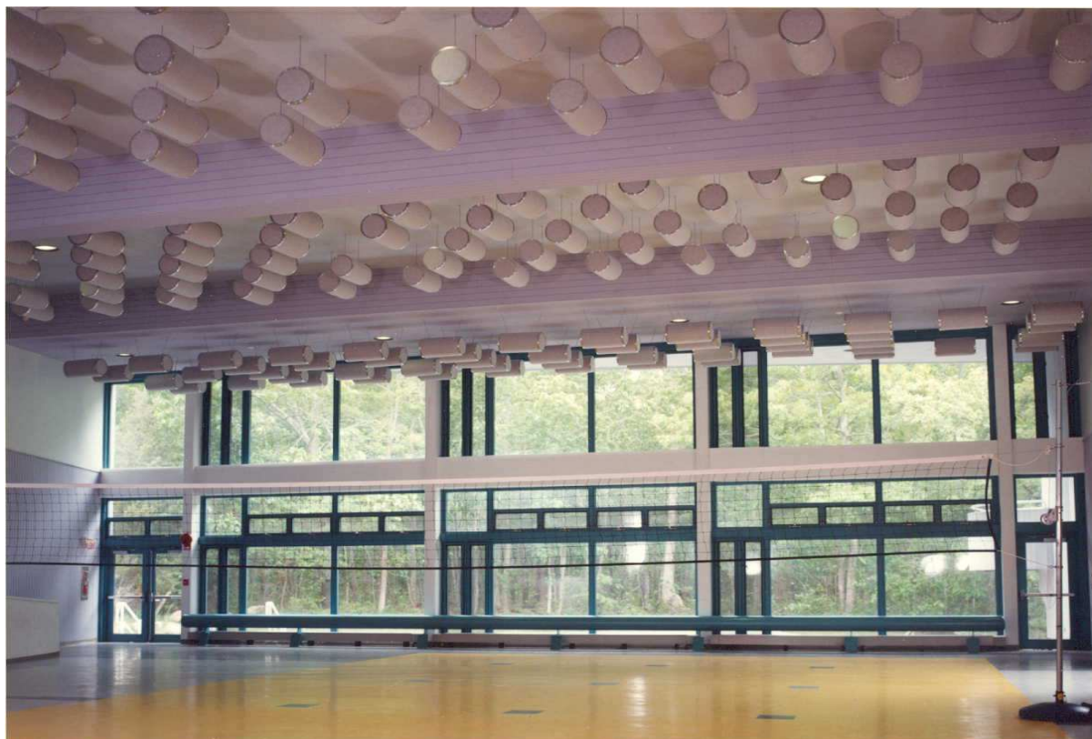
Fotografia przedstawia przeszkloną szkolną salę gimnastyczną z podwieszonymi pod stropem rolkami dźwiękochłonnymi.
